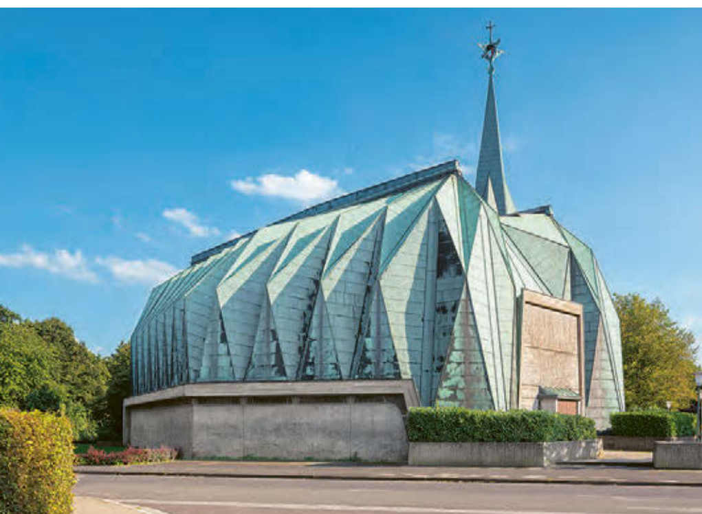
Das gefaltete Kupferdach von St. Paulus in Weckhoven reicht bis auf den Boden
