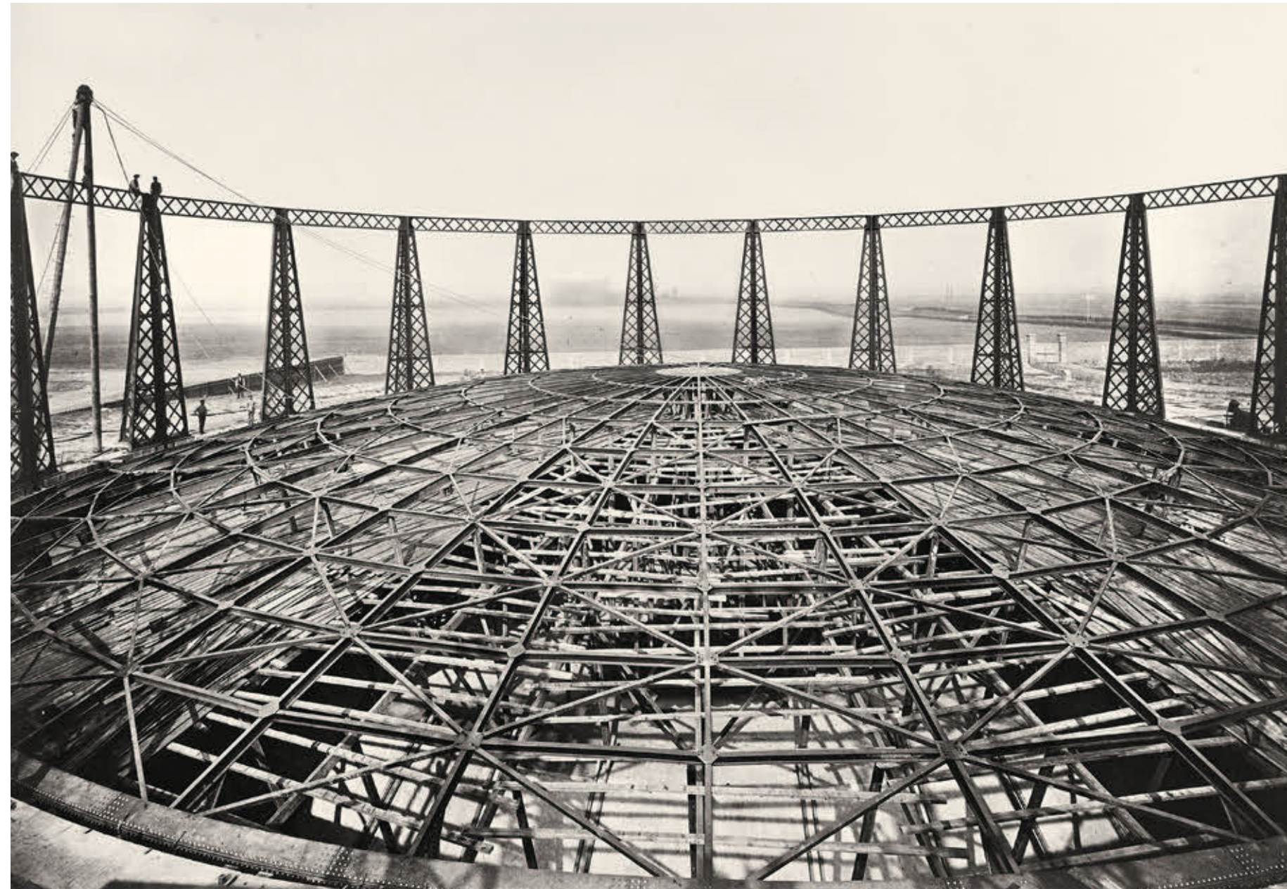
Kuppelkonstruktion eines Gasspeichers an der Widdersdorfer Straße in Ehrenfeld für die Betriebsanlagen einer neuen Gasfabrik, links positionierte Arbeiter lassen die Dimensionen des Tragwerks erkennen; Fotografie von Johann Heinrich Schoenscheidt, 1876
