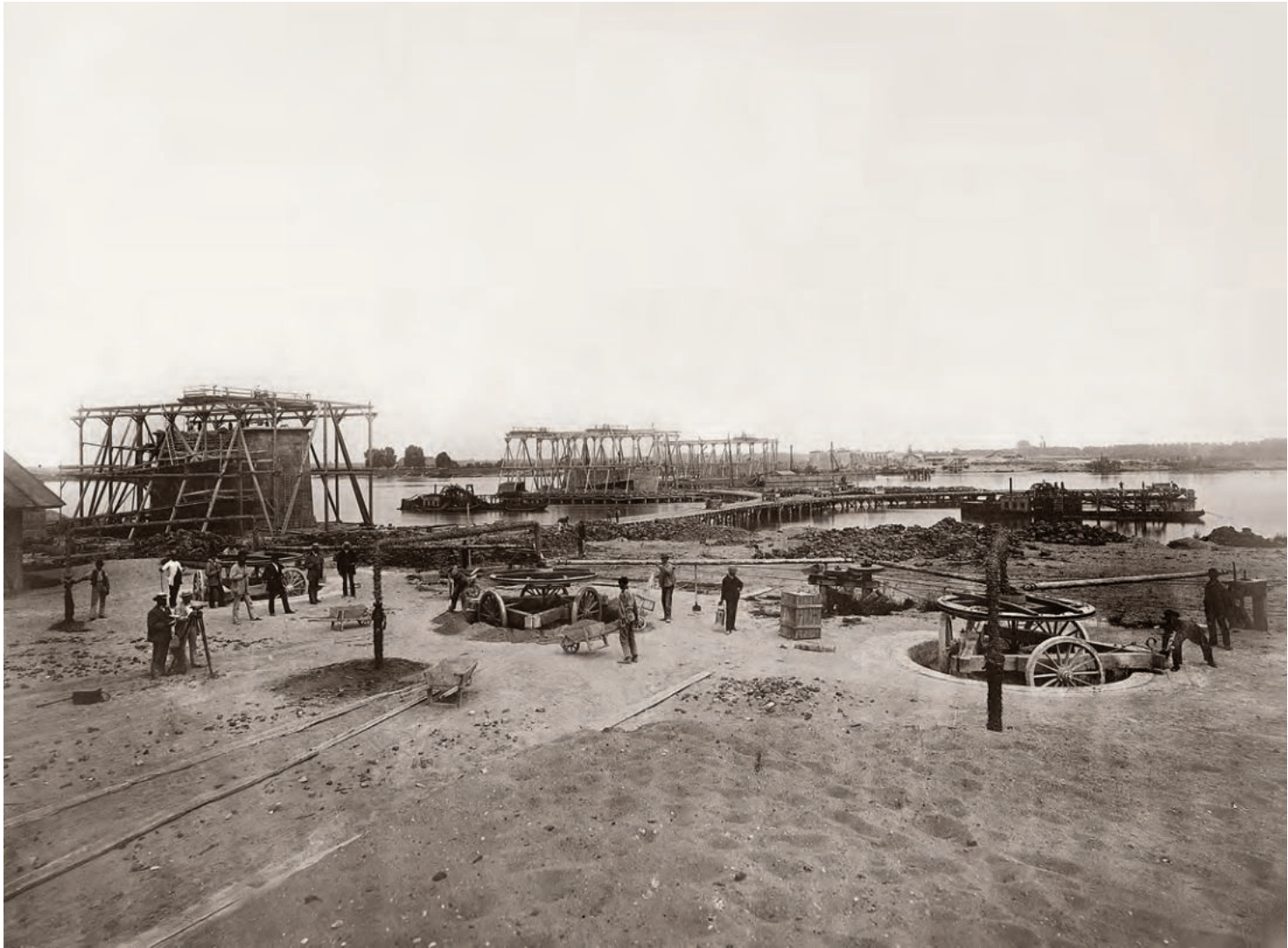
Theodor Creifelds sen. Baustelle der Eisenbahnbrücke über den Rhein bei Wesel 1872-1874
